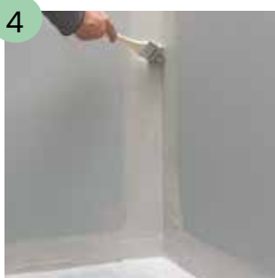
4 AquaStop påføres i hjørner og overgang gulv/vegg.
