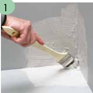
1 Start med å påføre Casco AquaStop smøremembran i hjørnene.
