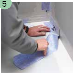
5 I den våte membranen legges WetStop tettebånd. Pass på at båndet ikke får hulrom bak seg. Ved skjøter bør det være ca. 5 cm overlapp.
