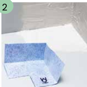
2 Legg hjørnemansjetten i våt membran.
