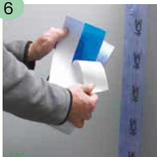
6 Som et alternativ kan man bruke selvklebende WetStop tettebånd.
